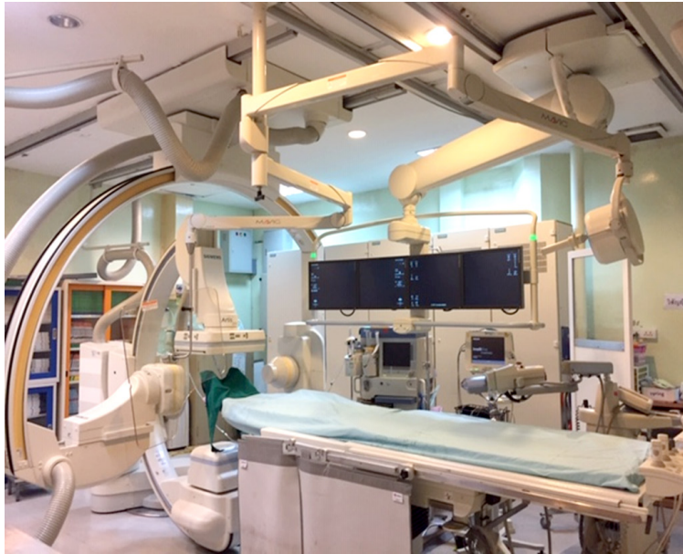
รูปที่ 1 เครื่องเอกซเรย์ส่องตรวจหลอดเลือดที่ใช้ในหน่วยรังสีร่วมรักษาระบบประสาทเป็นชนิด 2 ระนาบ ยี่ห้อซีเมนส์ รุ่น Artis Zee
